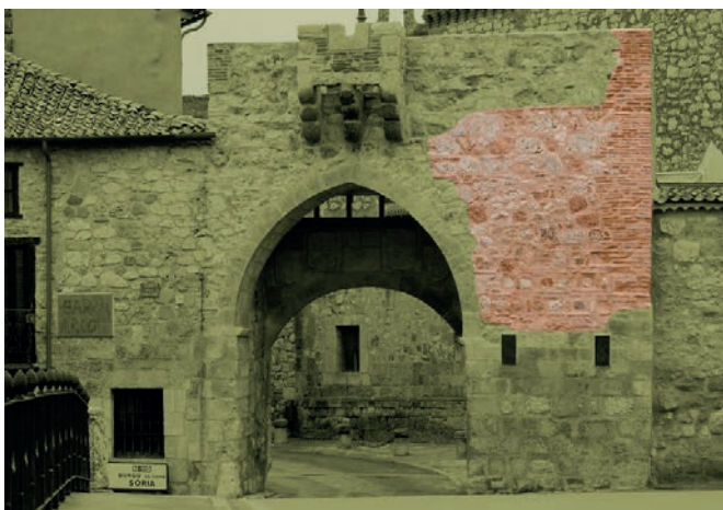
Figura 8. Fachada exterior del Arco de la Villa de la muralla de Ayllón, inmediata al cauce del río Aguiasejo tras su última restauración. Fotografía y composición del autor (2015).
