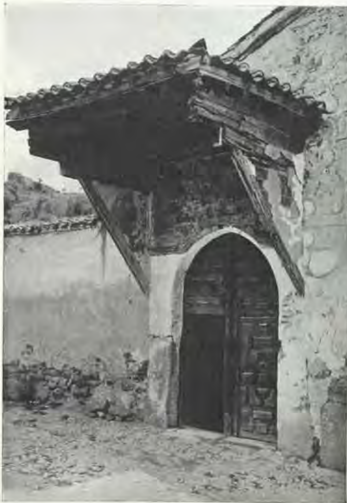
BUITRAGO.—MARQUESINA DE LA ENTRADA AL HOSPITAL.
